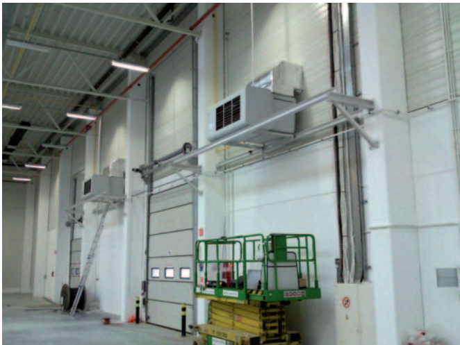
RIPRESA SOLO ARIA ESTERNA INTAKE OF ONLY EXTERNAL AIR
