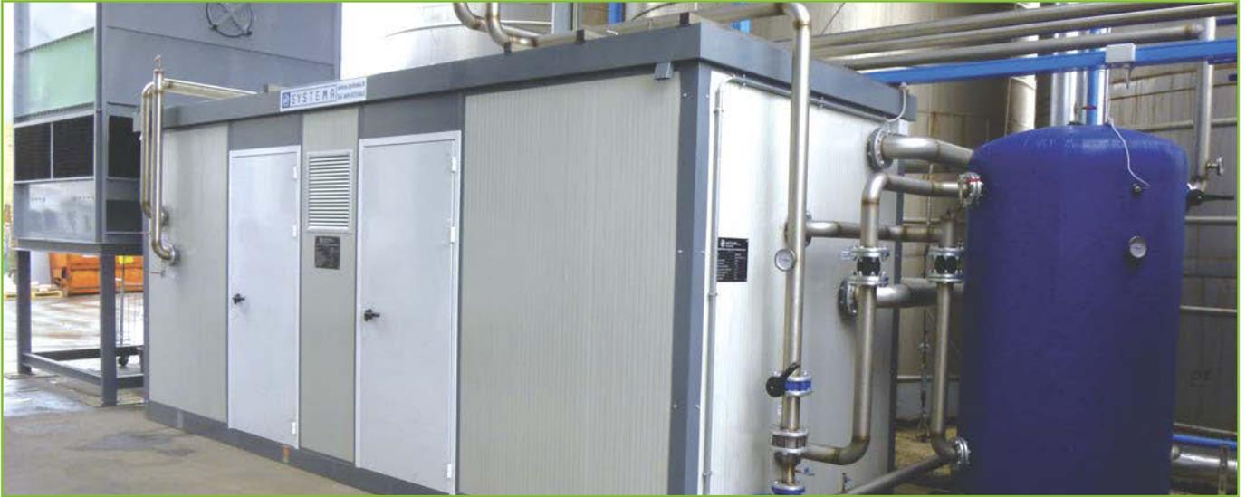
**Expo Milano: SOLAR-COOLING con concentratori solari ed Assorbitore ad ACQUA CALDA versione PACKAGE - Potenza frigorifera 70 kW
